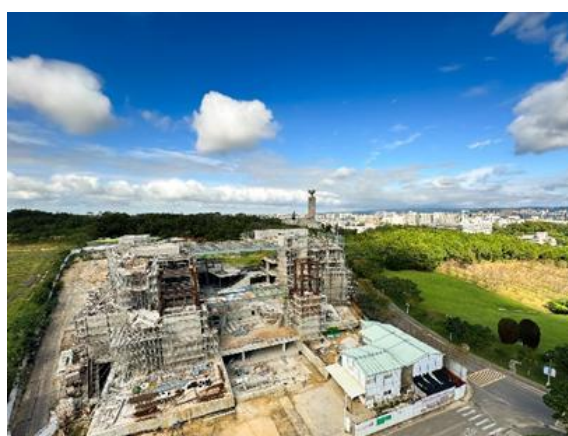
藝術學院大樓依山而建，基地保留北面原生林，目前工程進度已達 6 成。
